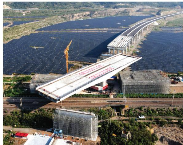
图为河南省济源市沿太行山高速公路跨焦柳铁路立交桥转体施工现场。8月11日,由中铁大桥局承建的河南省济源市沿太行山高速公路上跨焦(作)柳(州)铁路立交桥成功转体。转体主梁总长130米,总重量达2.1万吨。
