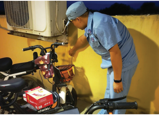
消防协管员深入辖区住宅小区,排查电动自行车违规停放充电等安全隐患。
