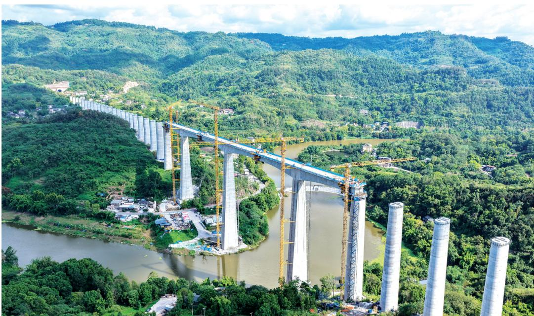
图为渝万高铁五步河双线特大桥梁建设现场。9月24日，由中铁十二局承建的渝万高铁五步河双线特大桥梁主跨顺利合龙，为全线按期通车奠定基础。五步河双线特大桥梁全长1796米，跨越S207省道及长江支流五步河。此次合龙的五步河双线特大桥梁主跨总跨度392米，最高墩达105米。渝万高铁正线全长251公里，设计时速350公里，是国家“八纵八横”高速铁路主通道包(银)海、京昆通道的重要组成部分。 新华社记者 唐奕 摄
