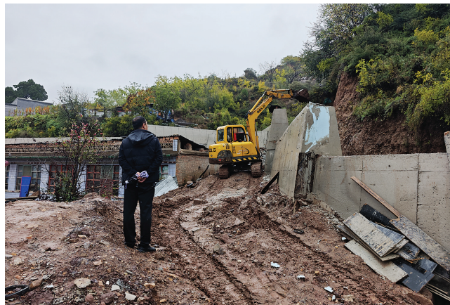
建设银行交城县支行驻水峪贯镇榆林村工作队员协助村里修缮坍塌围墙。
