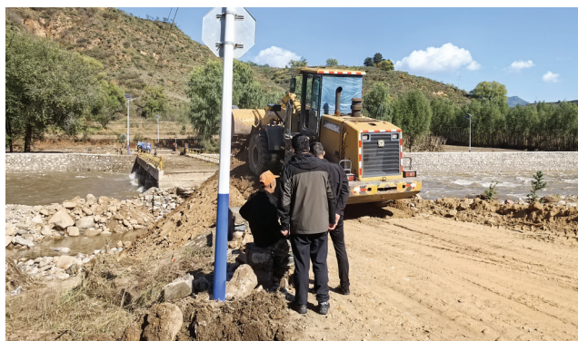
交城县应急局驻上斜村工作队员协助抢修进村桥梁。
