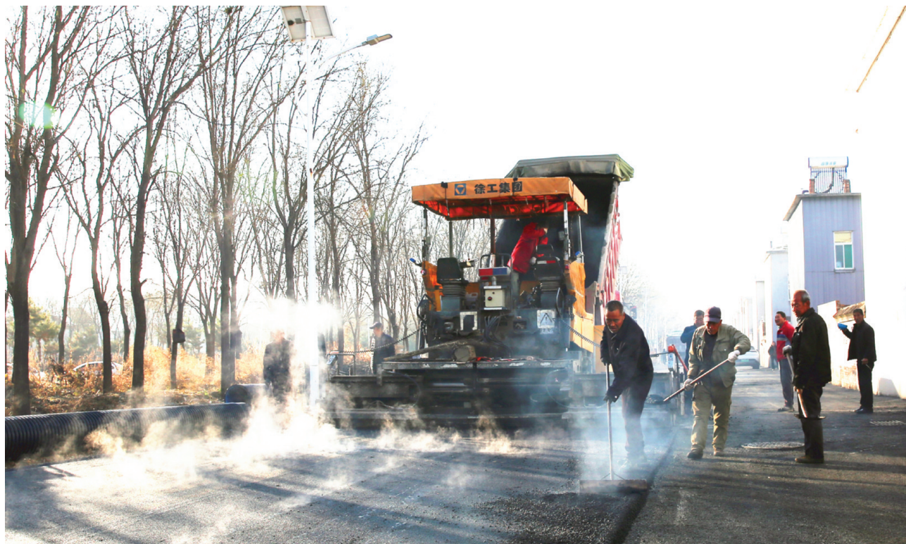
11月17日,方山县圪洞镇古贤村二区雨污分流项目进入铺油施工阶段。据了解,该项目新建管网2275米,污水主管网4096米(DN300)铺设沥青路面23714.7平方米,总投资1262.75万元,计划工期310天。肖继旺 摄
