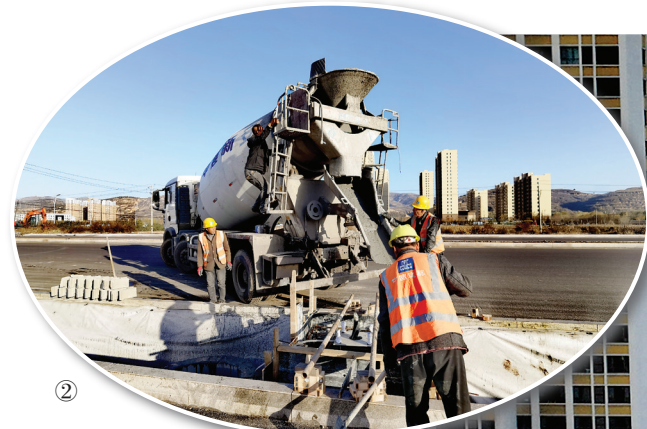
连日来,吕梁新安大道施工现场一派繁忙,双向八车道的交通大动脉雏形渐显,项目建成后,将15分钟串联机场、高速,让市民出行更便捷,为新区发展注入强劲动力。
