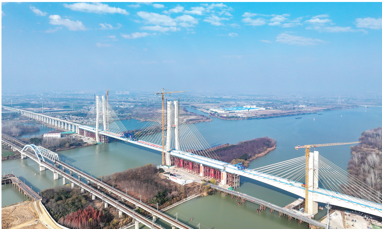
12月19日拍摄的通泰扬特大桥跨京杭运河斜拉桥合龙施工现场(无人机照片)。
