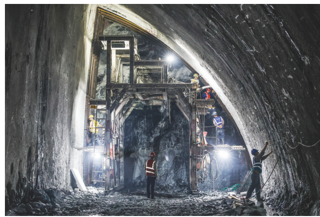
12月23日,施工人员在深圳外环田头山隧道群右线隧道和斜井隧道交汇处开挖作业。
