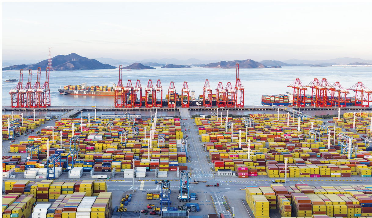
2025年12月4日拍摄的宁波舟山港穿山港区集装箱码头(无人机照片)。
