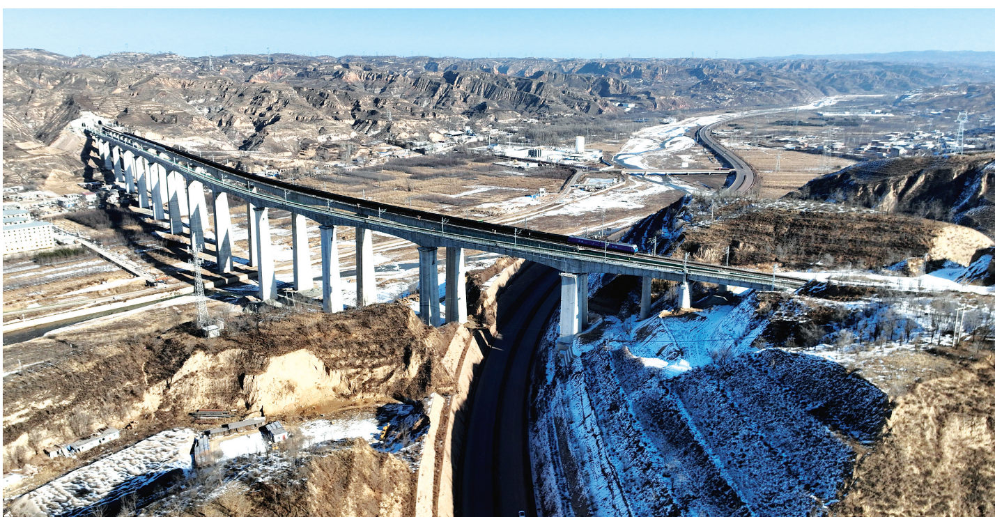
近日,一列和谐号货运火车正驶过“西煤东运”大道瓦店铁路起点的兴县瓦塘特大桥。冬日黄土丘陵间残雪点缀,高墩大桥横跨沟壑,在开阔地貌中格外醒目,既彰显出这条能源大通道起点工程的磅礴气势,也映照出其繁忙的运输活力。
