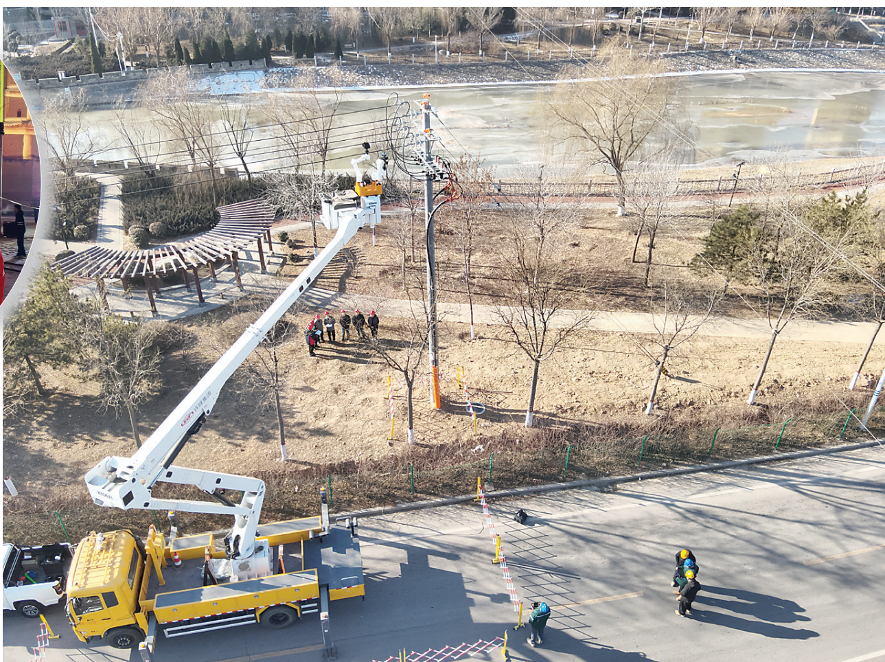
1月6日,国网汾阳市供电公司在10kV5720北峪线11#杆,成功应用双臂机器人完成带电安装接地环作业。本次作业采用“人机协同”模式,机器人依托精准定位技术完成标准化操作...
