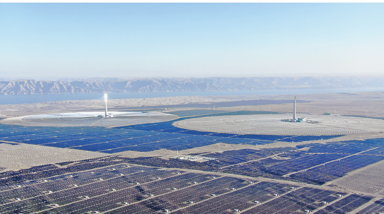
图为在青海省海南藏族自治州共和县塔拉滩绿色产业发展园区拍摄的光伏电站。
