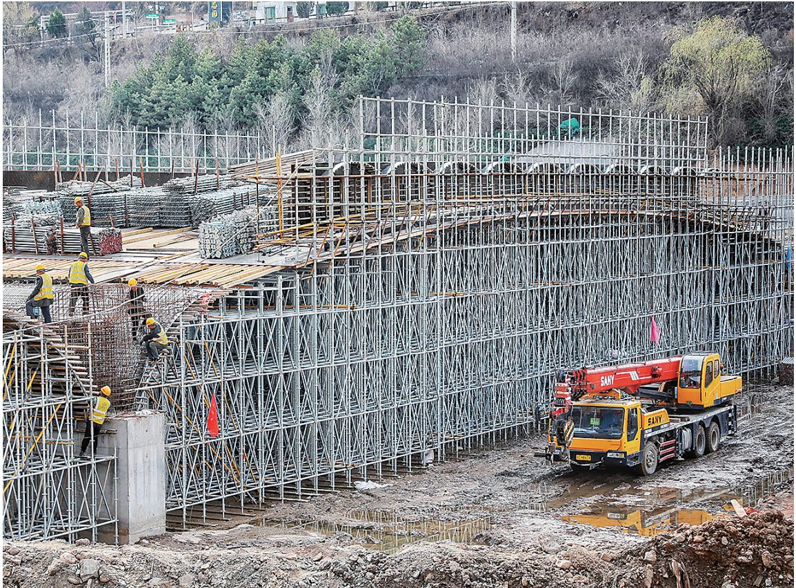
3月27日,柳林县重点民生工程——贺家沟南路跨河大桥施工现场机器轰鸣,建设者们正有序进行桥梁主体结构作业。该桥全长133.6米、宽20米,采用现浇预应力变截面混凝土拱形梁结构,涵盖桥梁主体、装饰装修、绿化及管线迁移等配套工程。建成后有效缓解区域交通压力,促进城区与南岸互联互通。 王风云 摄
