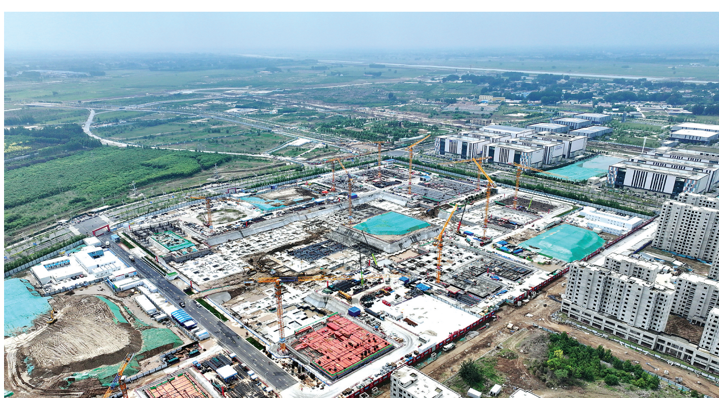
这是位于雄安新区的中国人民大学大中小学教育一体化综合改革示范基地项目建设现场(5月19日摄,无人机照片)。
