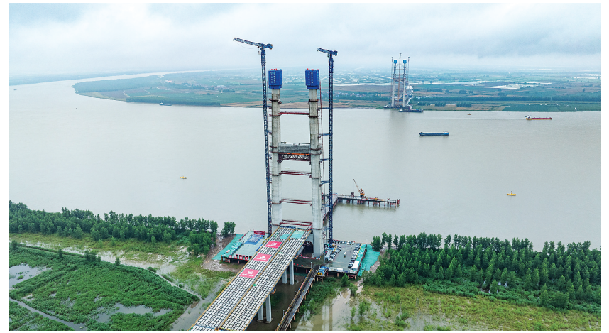
5月26日拍摄的汉南长江大桥建设现场(无人机照片)。
