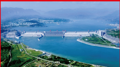
三峡水利枢纽是治理和开发长江的关键性骨干工程，是当今世界综合规模最大的水利水电工程。1994 年 12 月 14 日正式开工，2009 年建成，2010 年实现 175 米试验性蓄水。三峡水利枢纽建设创造了 100 多项世界之最，标志着中国水利水电建设技术达到世界先进水平。图为三峡工程全景。
