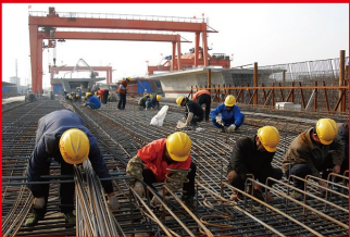
2008 年以来，面对国际金融危机带来的严重冲击，党中央按照坚定信心、冷静观察、多管齐下、有效应对的方针，有针对性地加强和改善宏观调控，保持经济平稳较快发展，着力保障和改善民生。图为 2009 年 2 月，京沪高铁镇江制梁场工地上工人们正在紧张施工。
