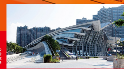
广深港高铁香港段全程 26 公里，于 2018 年 9 月建成通车，在香港西九龙站设立内地口岸区并实施“一地两检”通关安排。图为广深港高铁香港段西九龙站。
