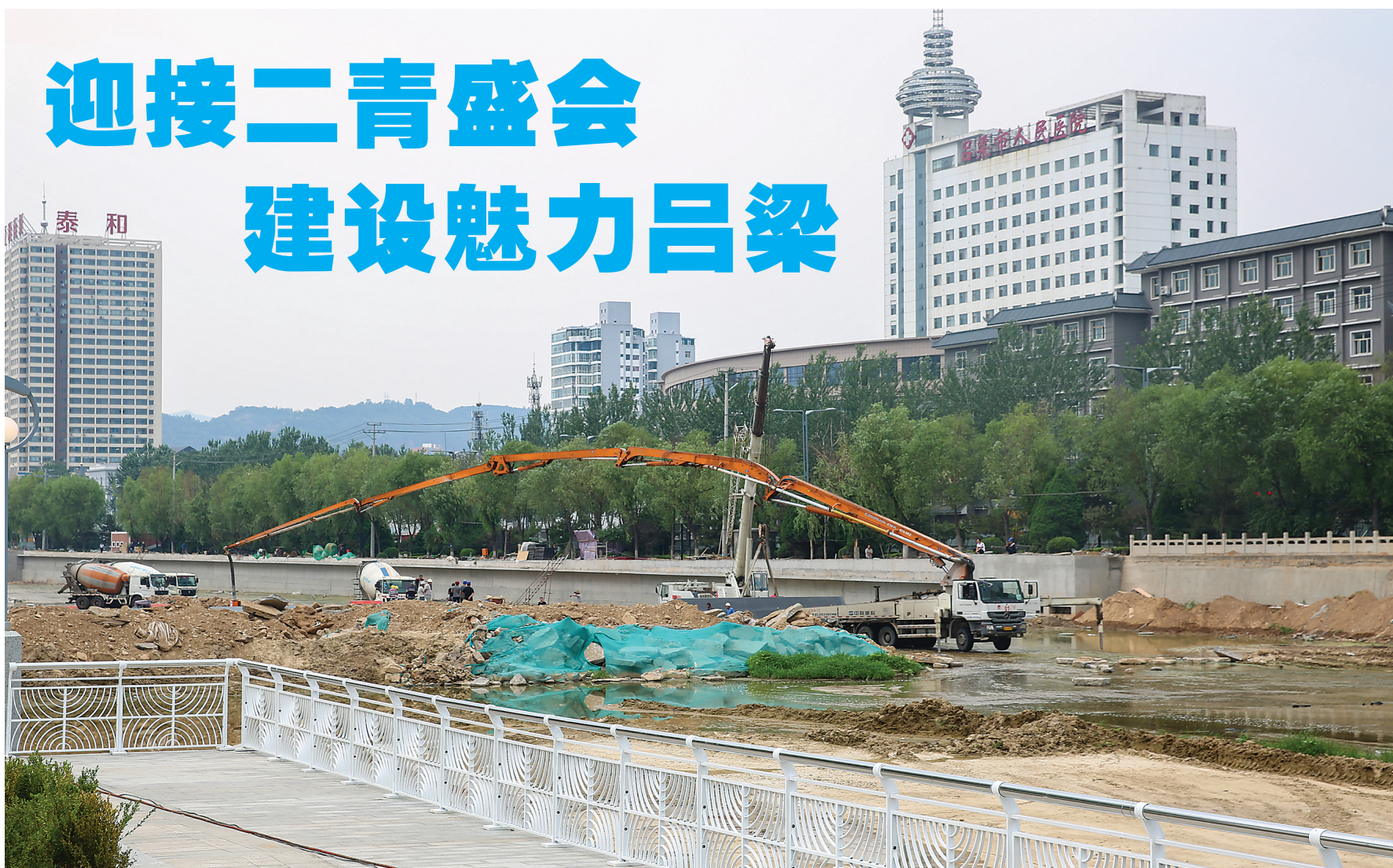
修建中的东川河蓄水改造工程
