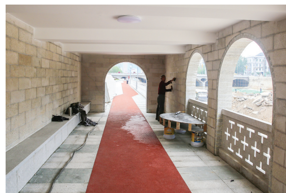
东川河带状公园内施工
