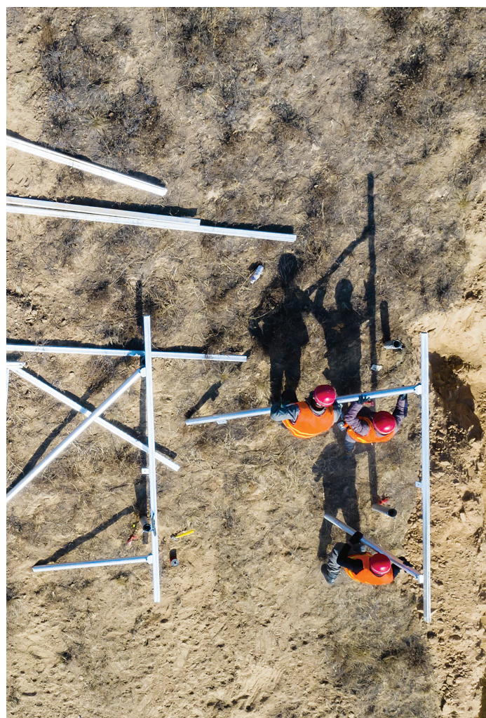
工人在安装光伏基建
