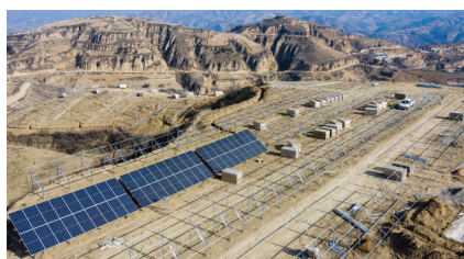
马家山15兆瓦光伏发电项目正在建设中
