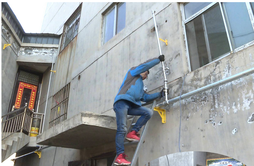
工人正在为住户安装天然气管道
