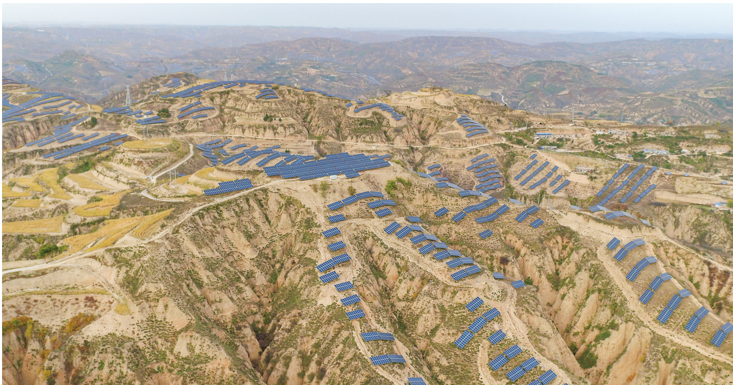
山头上铺满光伏发电板
