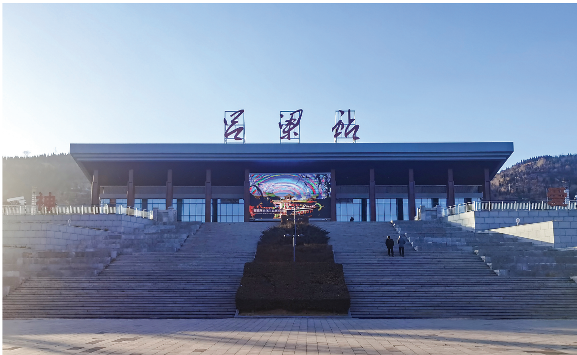
修缮一新的吕梁火车站
