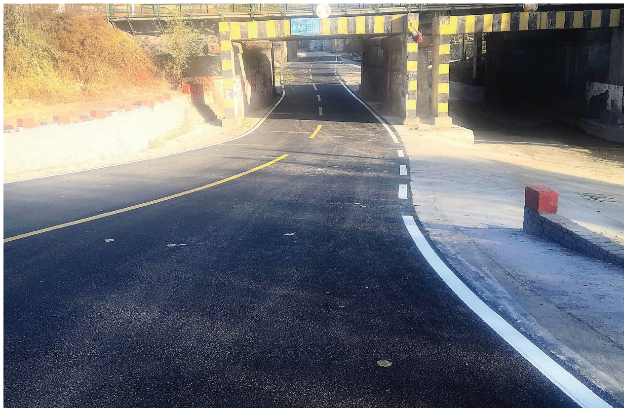
铺油后的进村路平坦宽阔
