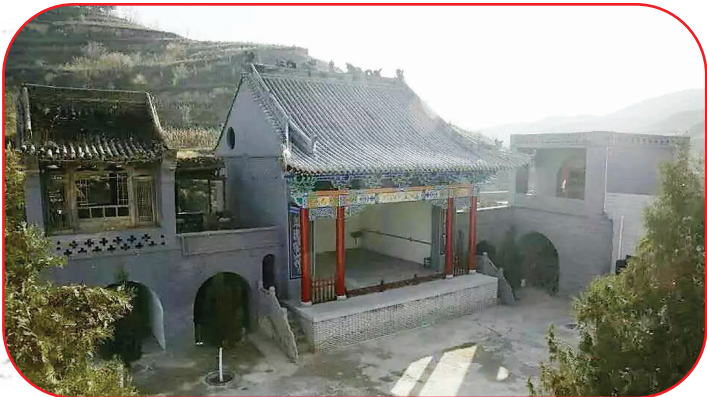
修葺一新的古戏台
