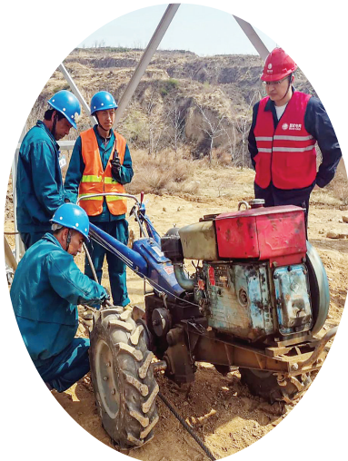
吕能施工人员正在展放导线
