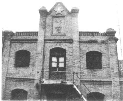
晋绥边区邮政管理局遗址(兴县城区)
