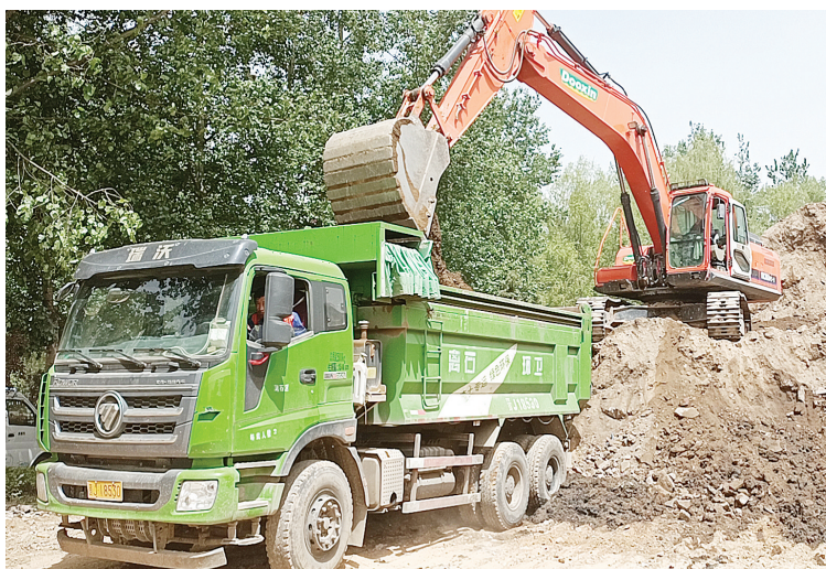
建筑垃圾清运车辆正在倾倒渣土
