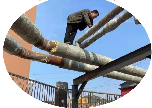
柳林县供热公司工作人员在室外检修管道
