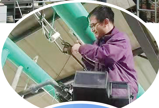
供热公司工作人员在检修站内管道
