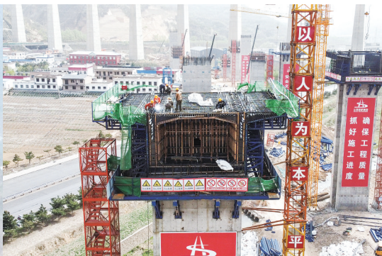
建筑工人施工建设
