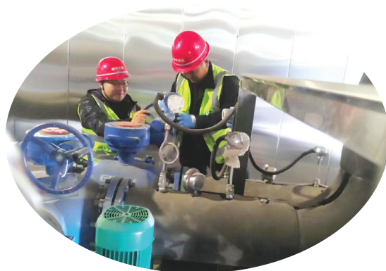
工作人员在柳林县锄沟桥底巡线检查
