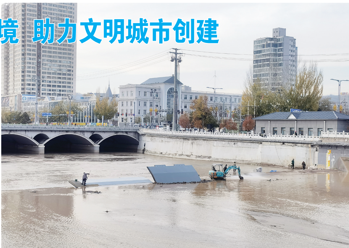
工作人员正在市区东川河河道清淤
