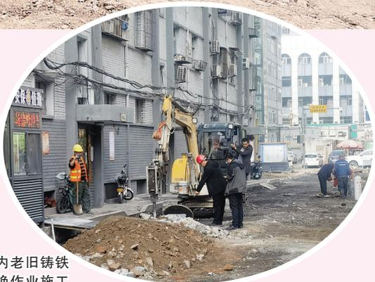
对小区内老旧铸铁管道进行更换作业施工
