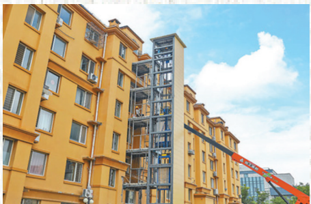
山东青岛福临社区,工人正在进行老旧小区加装电梯施工作业。张鹰 摄(人民视觉)
