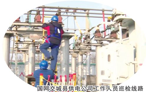
国网交城县供电公司工作人员巡检线路
