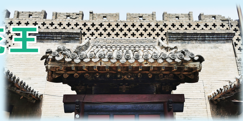
梁家堡砖雕门楼局部
