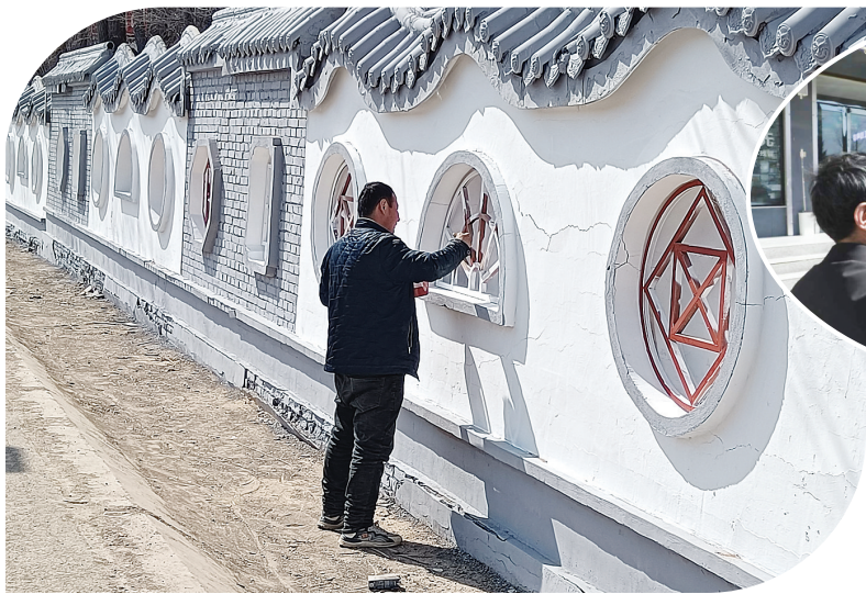
建筑外墙美化
