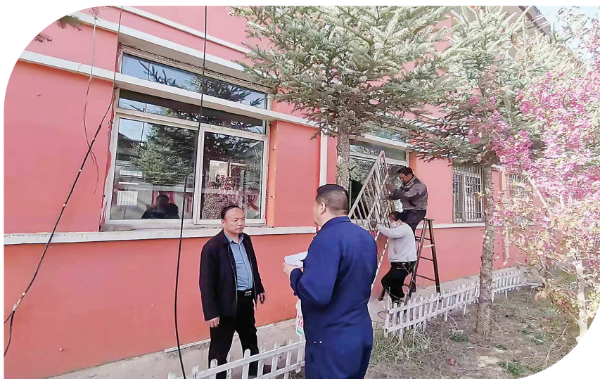
岚县消防救援大队拆除多业态混合生产经营场所防盗网(窗)
