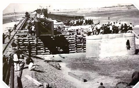
1949年12月,王强所在的第四支队石桥中队担当平汉铁路沙河铁路大桥的抢修任务
