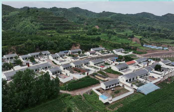
代家庄村改造后的“隐庐民宿”一角
