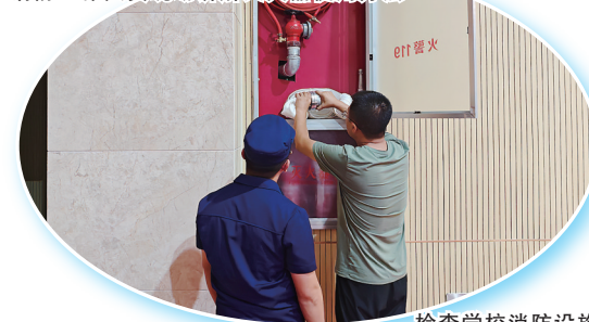
检查学校消防设施
