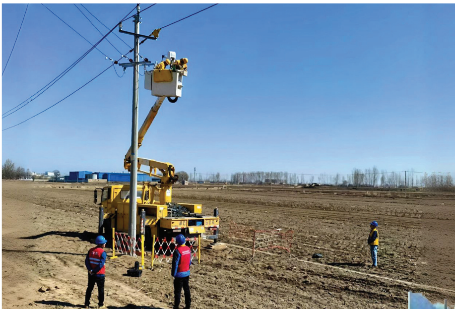
吕能公司专业人员在现场开展带电作业
