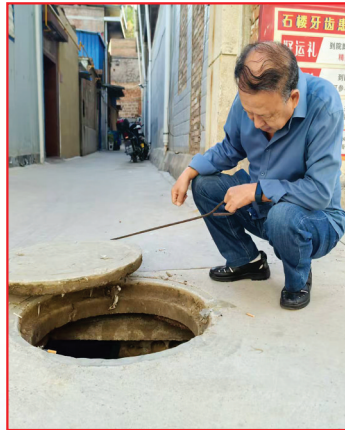
实地核查管道运行状态
