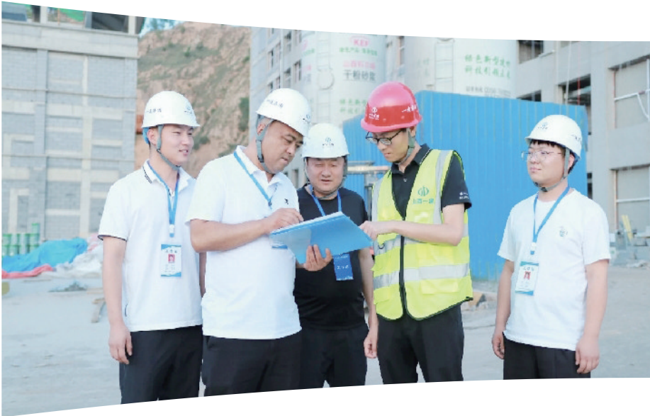
刘瑞伶在建筑工地与施工方讨论整治方案
