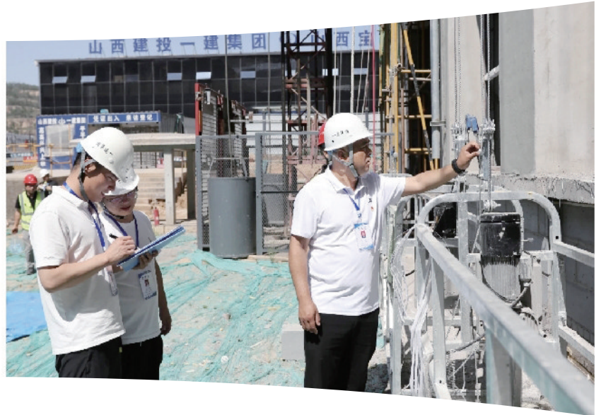
刘瑞伶巡查建筑工地安全情况
